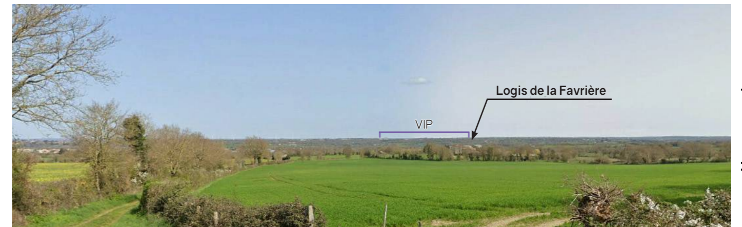
Photo 40 : Covisibilité directe entre le VIP et le Logis de la Favrière (GoogleStreetView)
